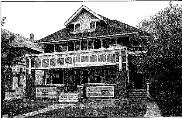
209-211 S. Elmwood Avenue (1905)
