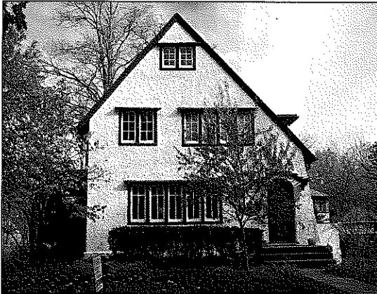
300 S. Elmwood Avenue (1904)
